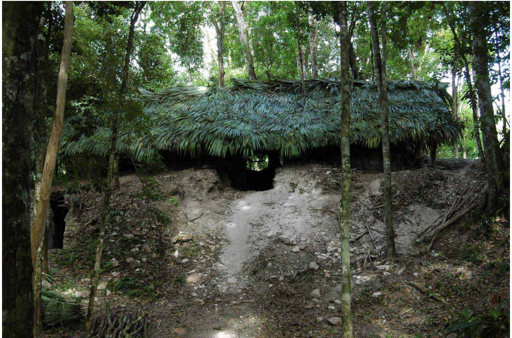
Figura 18. Estructura 43, Grupo III, Holmul después de la conservación de los pisos y bancas y la construcción de un nuevo techo.
