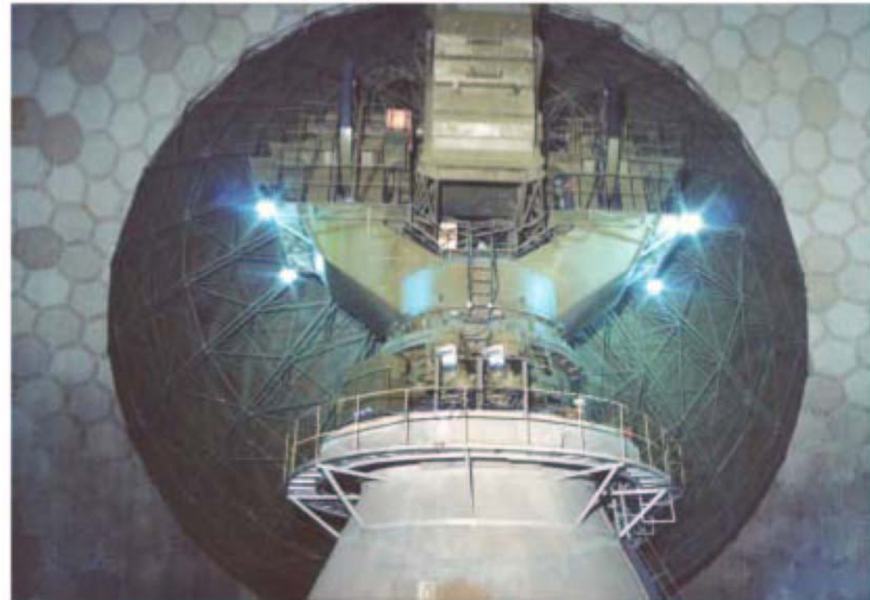
位于云南曲靖的直径25米的雷达天线及伺服齿轮
